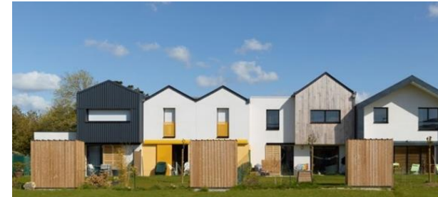
Opération groupée « Vert Buisson » à Bruz (35)
