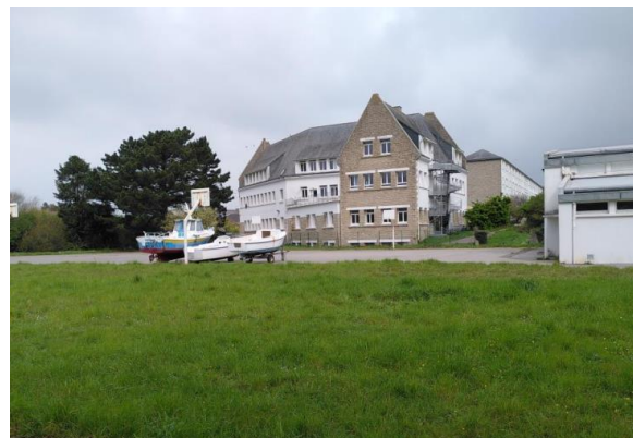
6 – Vue depuis la voie goudronnée, marquant la limite entre les parcelles YW0012 et YW0013, vers le gymnase, la surface bétonnée et le lycée
