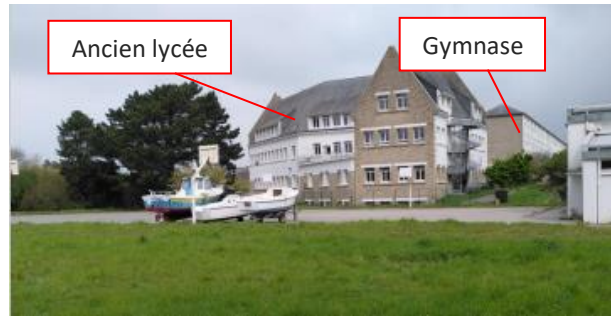
Vue sur le gymnase et le lycée, depuis l'espace enherbé (YW0013) au Sud du site de projet – Source : laoSenn
