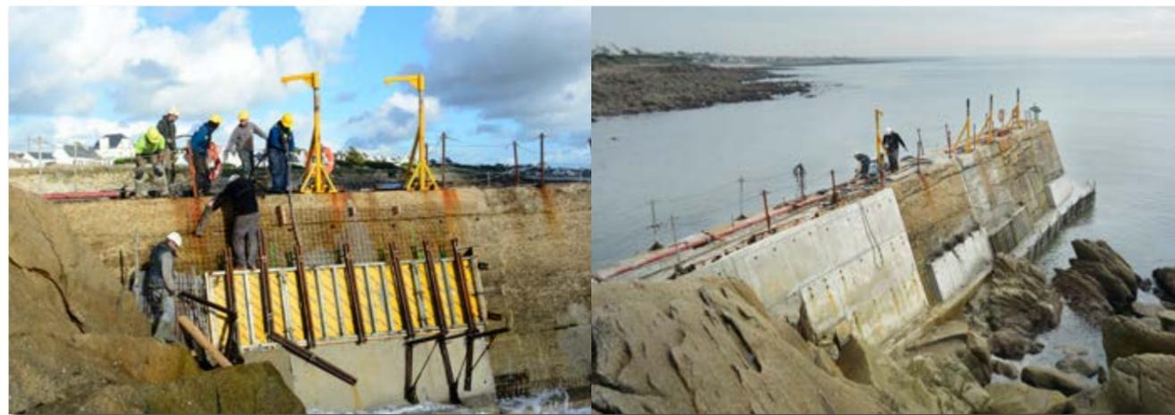
Les travaux de réfection de la digue de Pors Poulhan ont débuté fin août et se poursuivent. Ces travaux ont pour objectifs de protéger ce site de caractère, trait d'union entre le Cap Sizun et le Pays Bigouden, et de sécuriser l'accès au port pour les usagers. Ces travaux de grande ampleur ont nécessité l'intervention de plongeurs pour participer à la construction d'une assise indispensable à la consolidation de la digue.
