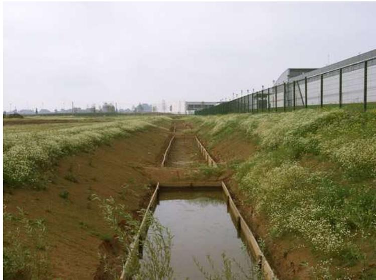
Figure 77 : exemple d'infiltration des eaux dans des noues et dans un puits d'infiltration
