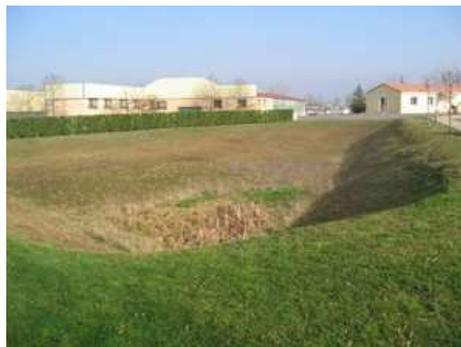
Figure 79 : bassin de rétention en forme de noue
