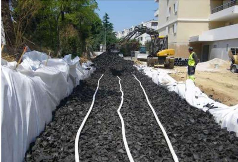
Figure 76 : exemple de dispositif d'infiltration des eaux pluviales
