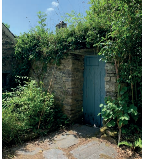
Murs de clôture
