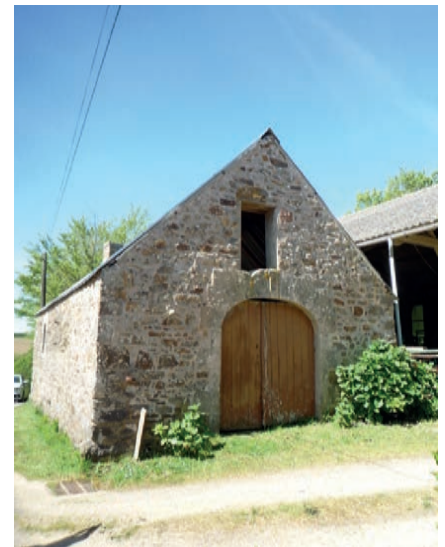
Grange avec porte charretière en pignon
