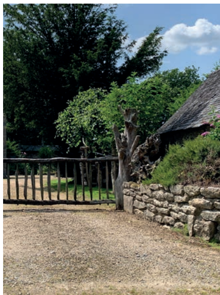
Muret en pierre associé à un portail en bois
