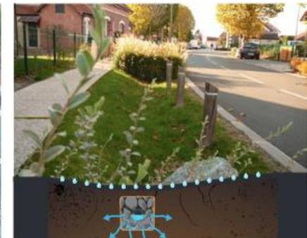
Noue avec tranchée d'infiltration
