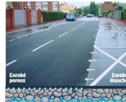
Chaussée à structure réservoir
