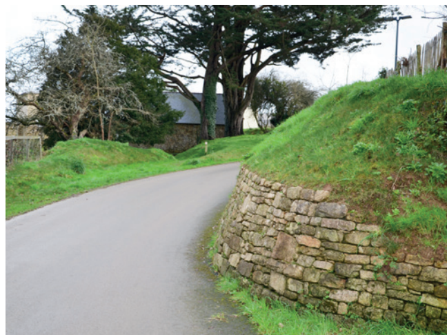
Soubassement empierré et talus enherbé
