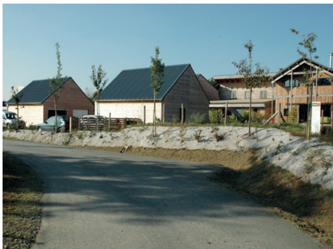
Un géotextile biodégradable favorisera l'installation des plantations tout en s'effaçant dans le paysage
