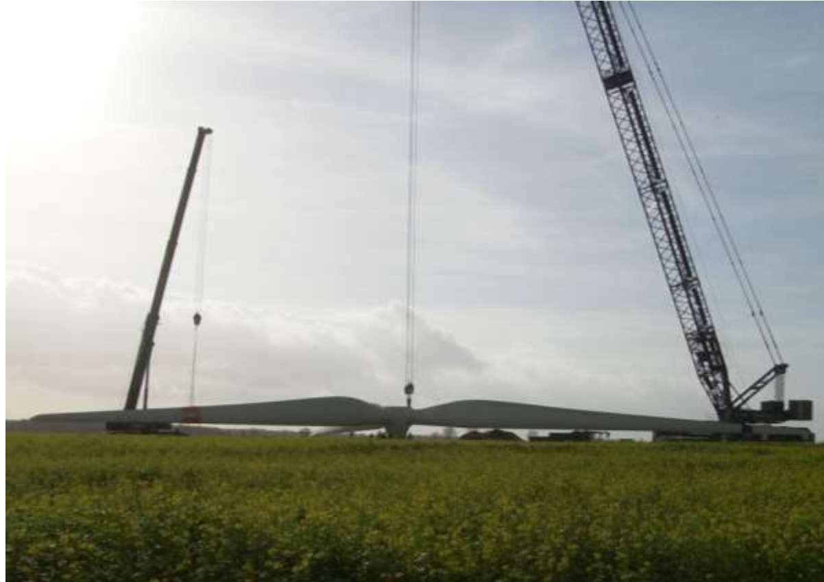
Photo 23 : Assemblage du rotor au sol
