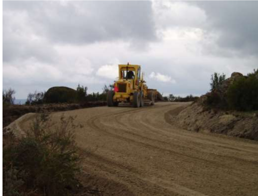
Photo 6 : Nivellement
