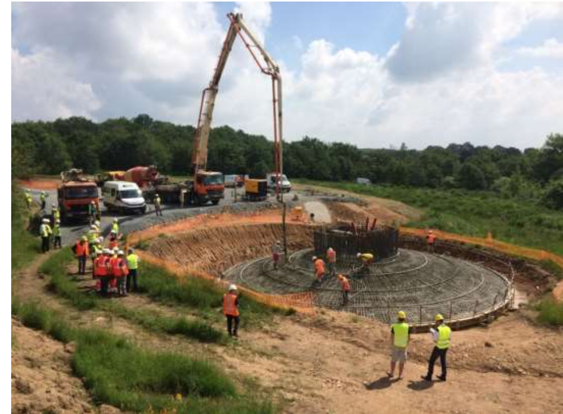
Photo 11 : Coulage du béton
