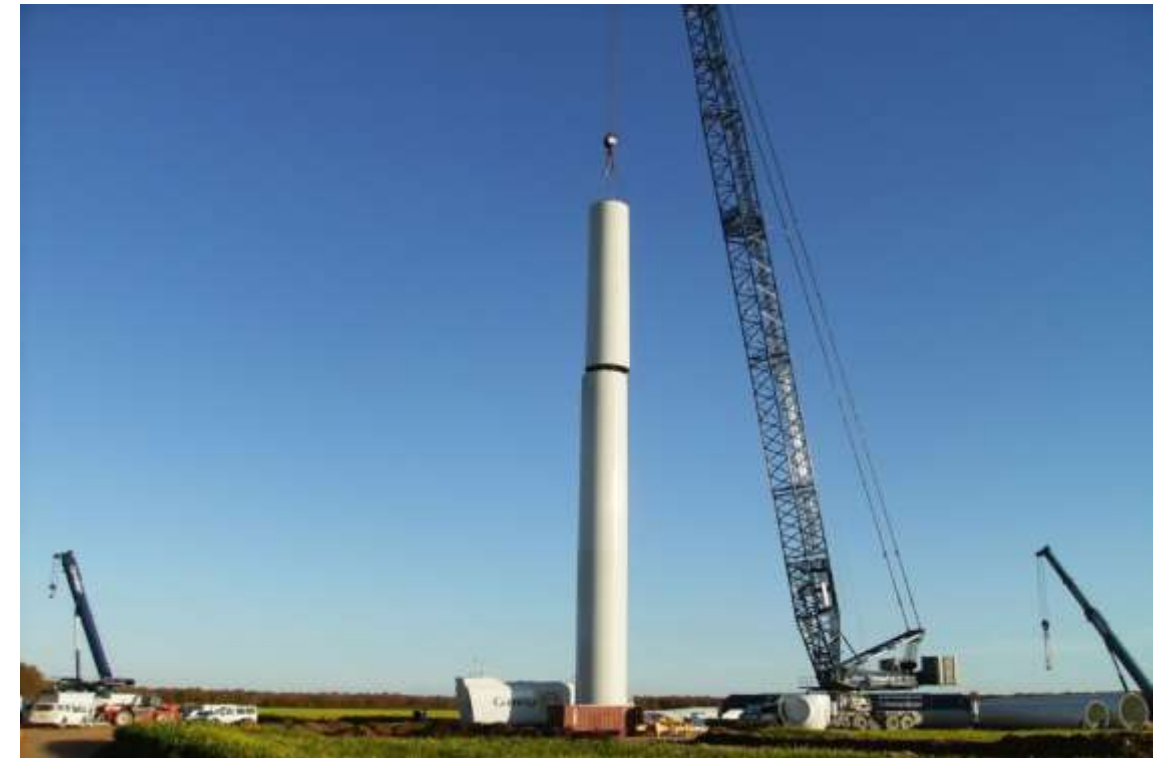
Photo 21 : Montage des éléments de la tour
