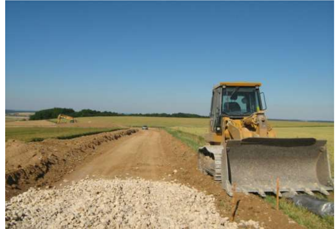
Photo 4 : Décapage du sol
