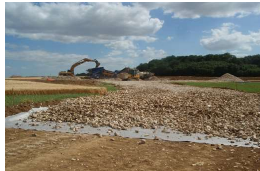
Photo 5 : Suivant le besoin, pose d'une bâche textile et de graves concassées
