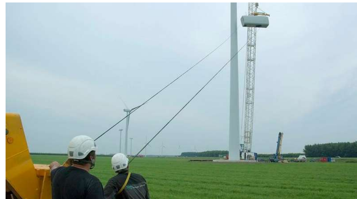
Photo 22 : Montage de la nacelle
