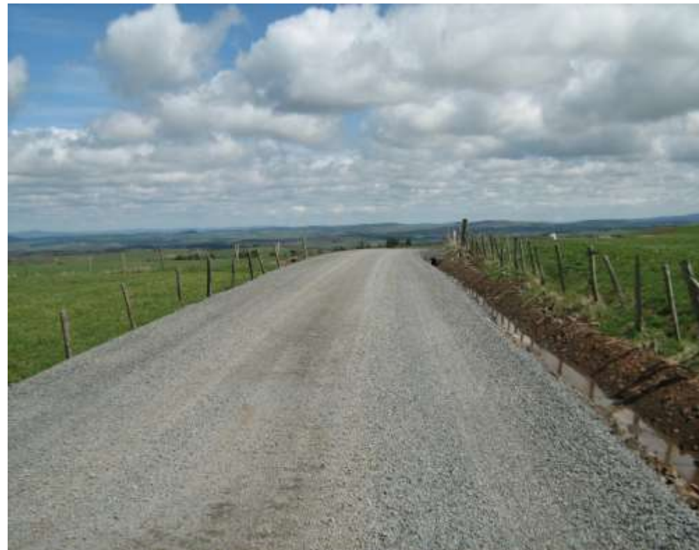
Photo 7 : Voie d'accès terminée
