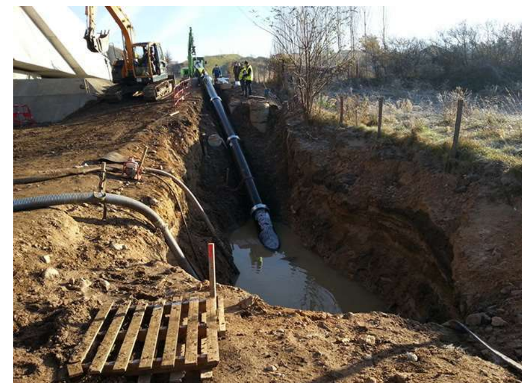
Photo 19 : Exemple de point de départ avec canalisation engagée
