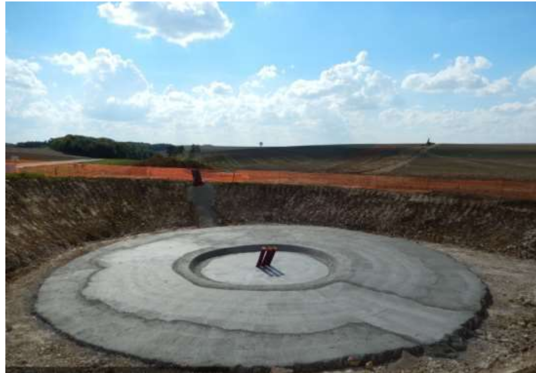
Photo 9 : Béton de propreté
