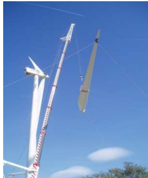
Photo 25 : Montage pale par pale
