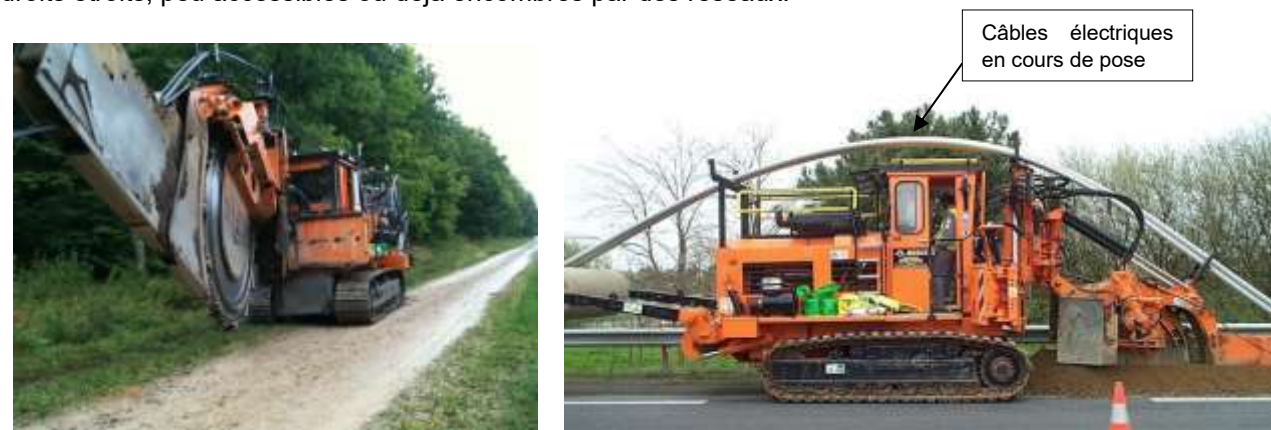
Photo 17 et Photo 18 : Trancheuse à l'arrêt et en action
