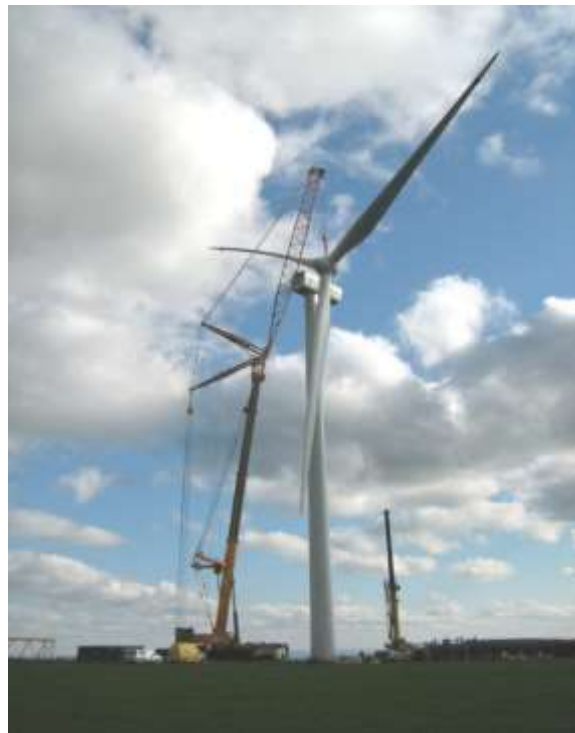
Photo 24 : Montage du rotor
