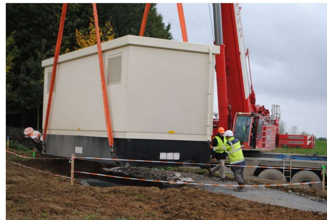
Photo 16 : Pose d'un poste de livraison
