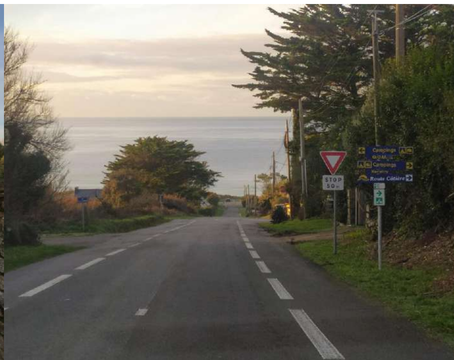
Bandes cyclables sur chaussée et signalétique touristique vers la plage de Mesperleuc. Jalonnement V45.
